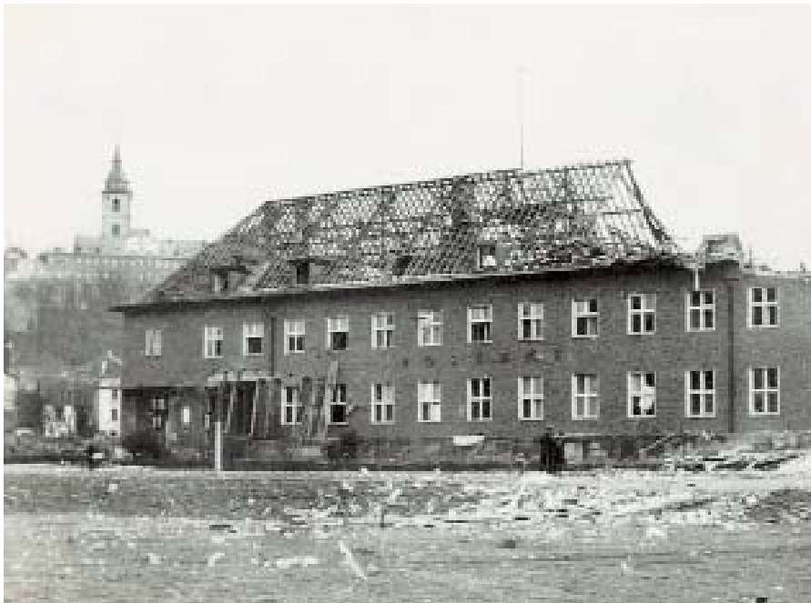
Neue Poststraße am 1. Januar 1945, nach dem Luftangriff vom 28. Dezember 1944, Foto: † Josef Schneider
