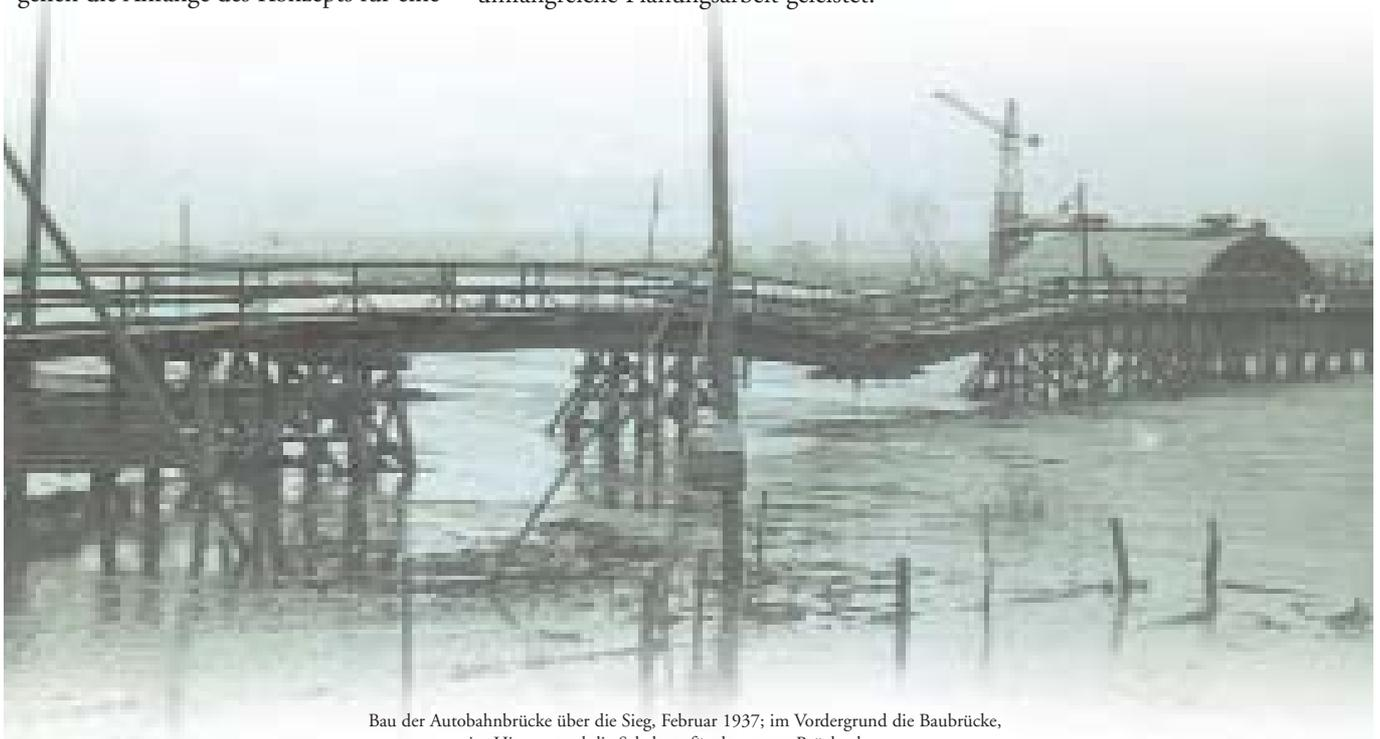
Bau der Autobahnbrücke über die Sieg, Februar 1937; im Vordergrund die Baubrücke, im Hintergrund die Schalung für den ersten Brückenbogen
